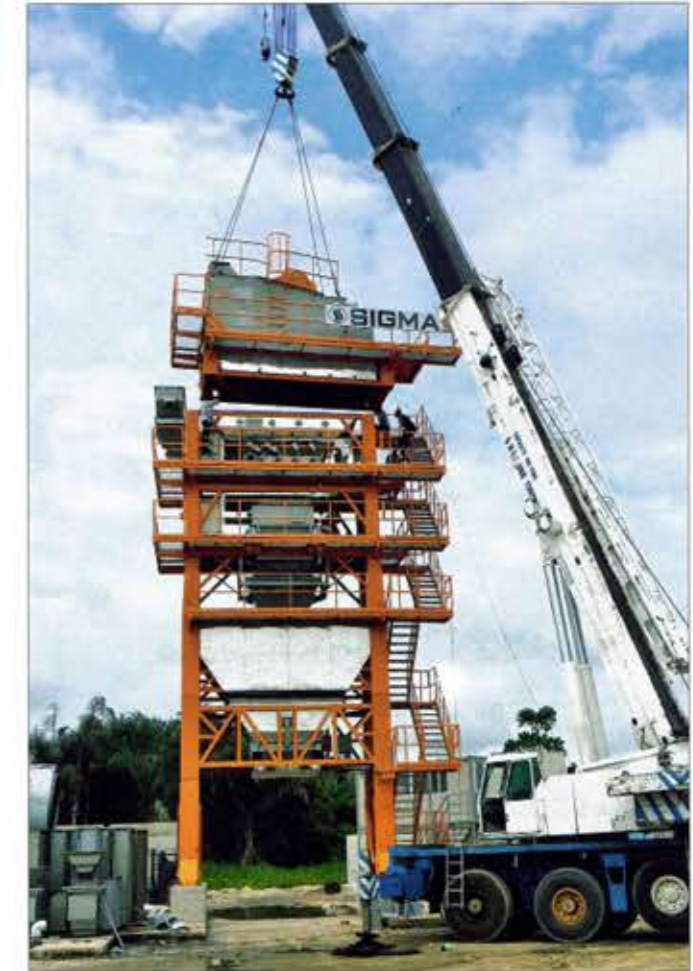
SIGMA Compact tip plentler Konteynerlere sığacak şekilde tasarlanmıştır
